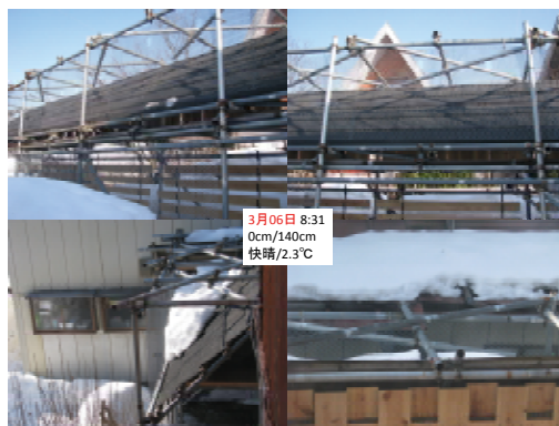
写真 2 自然融雪式勾配型雁木屋根の積雪と融雪の様子
