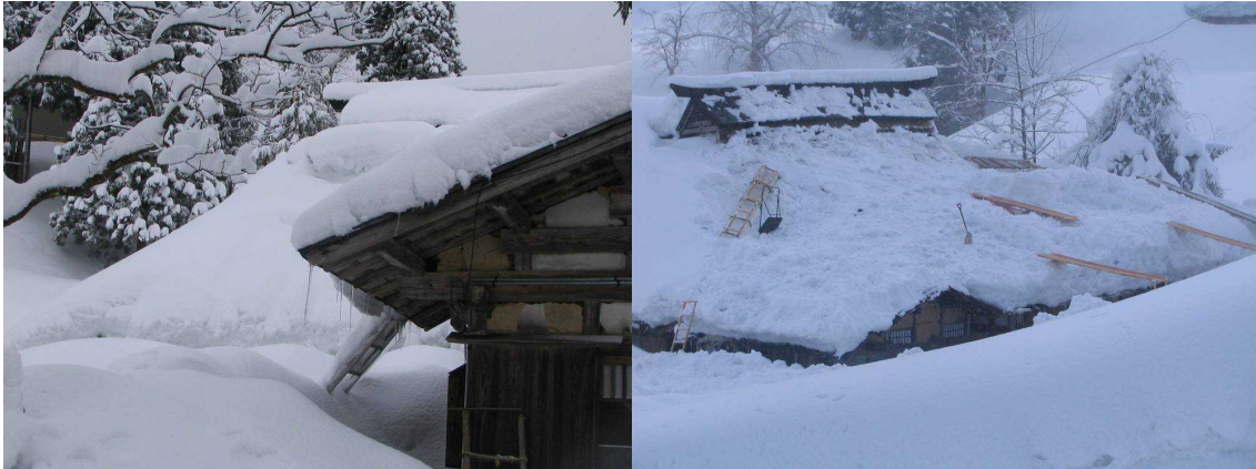
写真 5 第 5 回の雪下ろし風景 2 月 12 日 積雪 4.0m
