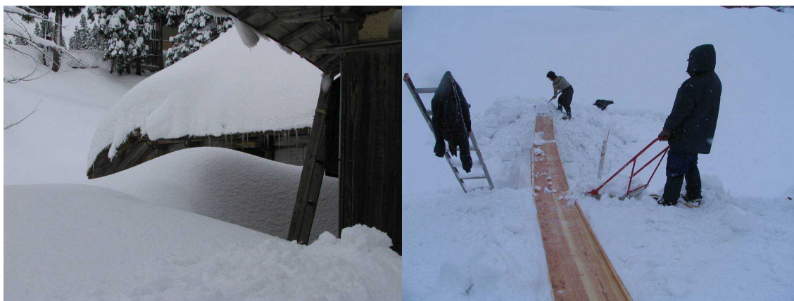
写真4 第4回の雪下ろし風景 1月28日 積雪3.1m
