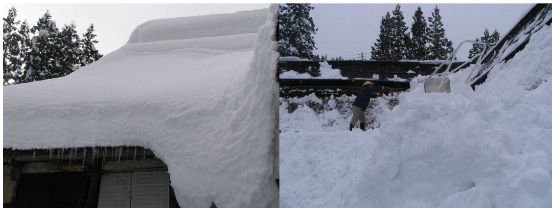
写真1 第1回の雪下ろし風景 12月17日 積雪 2.0m
