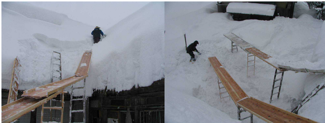
写真3 第3回の雪下ろし風景 1月7日 積雪3.3m
