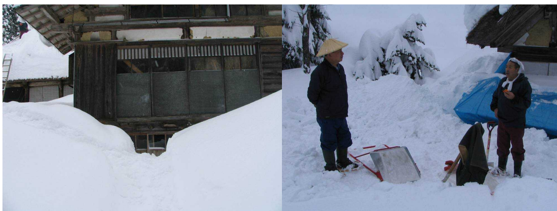
写真2 第2回の雪下ろし風景 12月29日 積雪 2.8m
